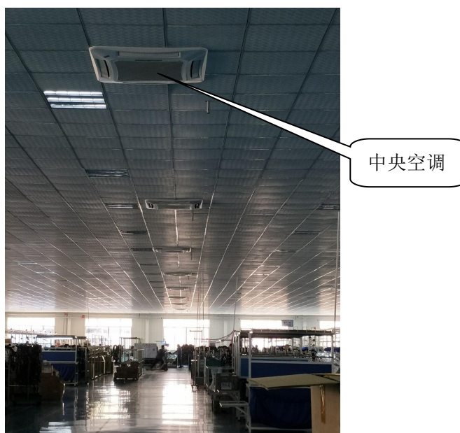
图 2-3 中央空调通风设施
